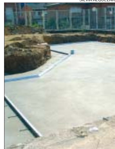
>> Obres de la piscina exterior
